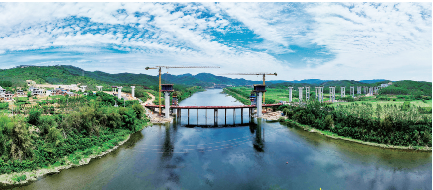
▲5月1日,柳州高速过境线公路(罗城经柳城至鹿寨段)洛清江大桥施工现场。(无人机拍摄)
