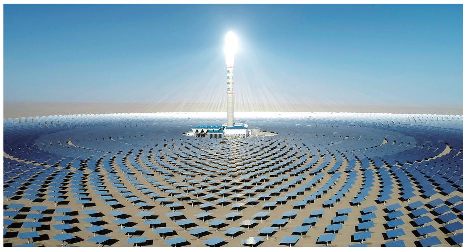
▲敦煌100兆瓦熔盐塔式光热发电项目。
