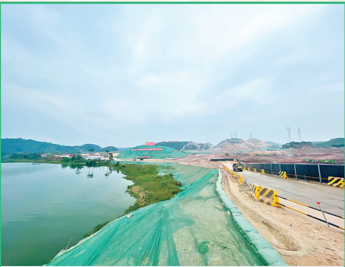
平陆运河青年枢纽工程的施工现场。 黄浩云 摄
