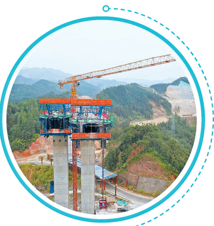
▲融安至从江高速公路一期工程(融水段)下四赖2号大桥正在施工。
