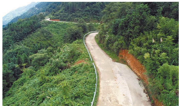
▲现在:带有安全护栏的水泥通村道路。
