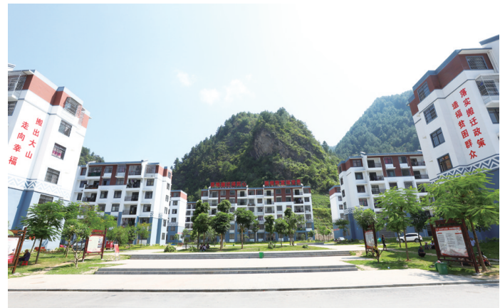
▲六能易地扶贫搬迁安置点中心广场。
