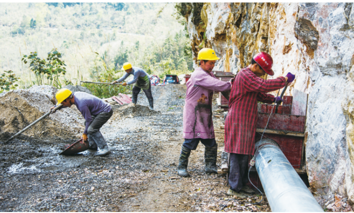
▲环江毛南族自治县下南乡饮水工程施工现场。 蒙壮科 摄
