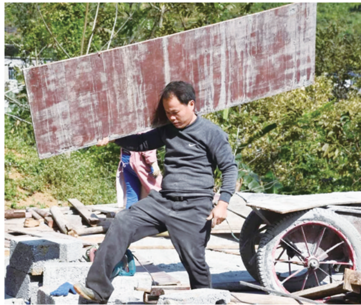
▲罗仕林在建筑工地上务工。
