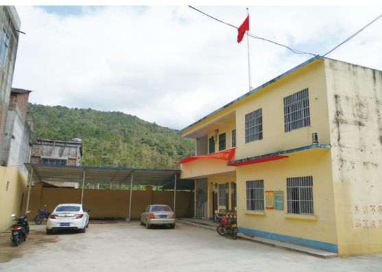
◀改造后的派台村委办公楼面貌焕然一新。
