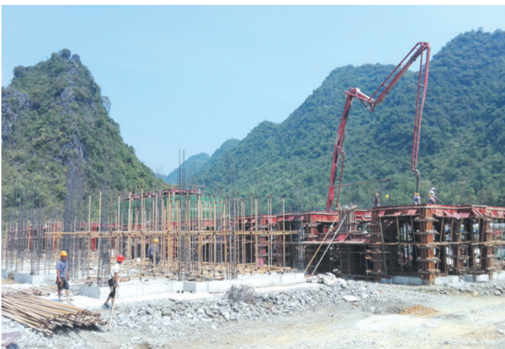
▲下坳车家庄安置新区在建设当中。
