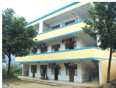
▲宽敞整洁的学生宿舍楼。
