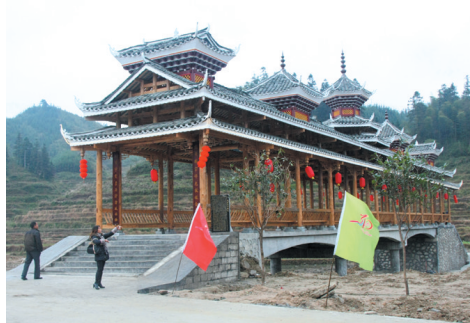
▲新建的滚贝吉祥风雨桥。
