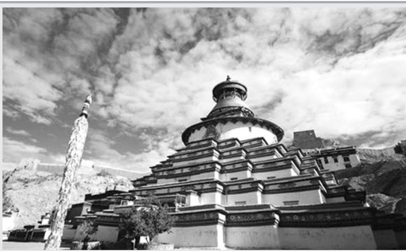
白居寺始建于明宣宗宣德二年(1427年),历时10年竣工。它是一座塔寺结合的典型藏传佛教寺院建筑,塔中有寺、寺中有塔,寺塔浑然天成,相得益彰,它是唯一一座完整保存到今天的寺塔,有西藏塔王之称。
