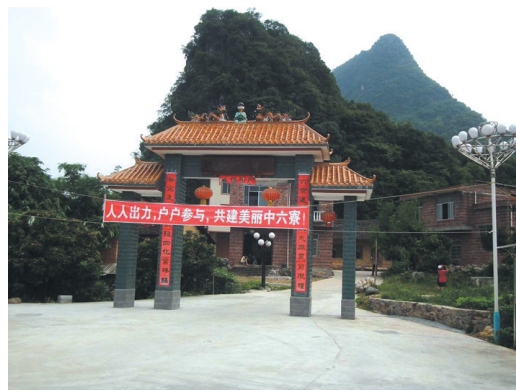
▲浮石镇六寮屯的大门威严屹立,雄伟壮观。
